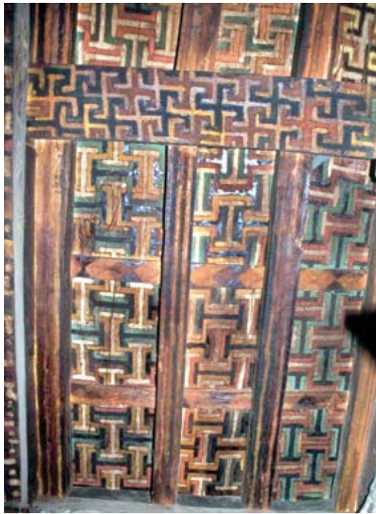
8. Əməkina Mədəhane Aləm church, south aisle ceiling
