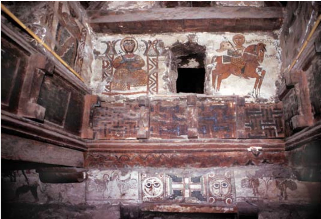
10. Զմակինա Մաժինե Ալամ church, west wall of the nave above entrance portal
